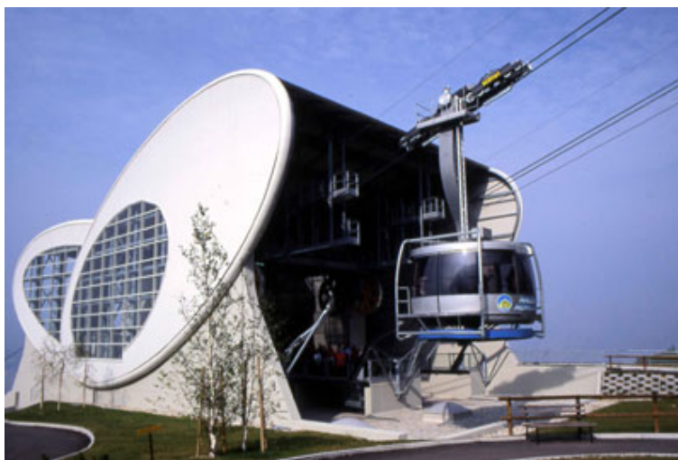
Figura 12 - stazione di partenza della funivia del M. Baldo, (Fonte: http://www.funiviedelbaldo.it/funivia.asp )
