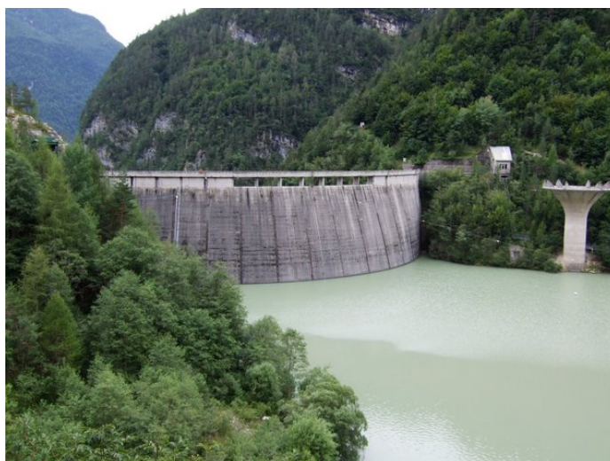
Figura 49 - diga di Pontesei, (Fonte: http://picasaweb.google.com/lh/photo/pvRdb_11dkF4M9BqhcEyag )
