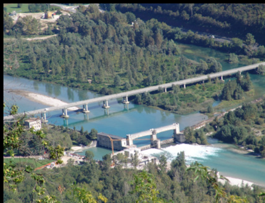
Ponte di Fener
