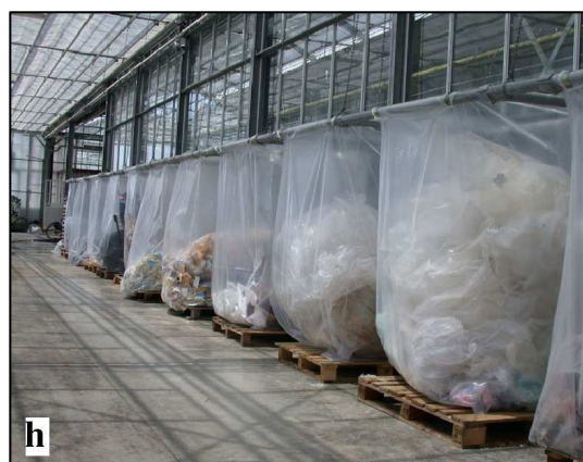
Figura 6.2 - Immagini di locali presenti all'interno di complessi serricoli di grandi dimensioni ricavati all'interno di strutture che, sebbene costruttivamente assimilabili a quelle di una serra, ne differiscono per la sistemazione della pavimentazione (adatta al passaggio di mezzi meccanici pesanti) e per l'utilizzo di materiali di copertura (in special modo sul tetto), traslucidi o addirittura opachi.
